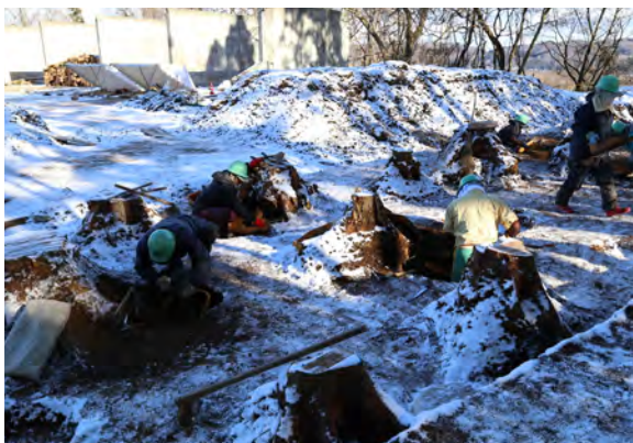
二子城跡：雪の中の作業風景
