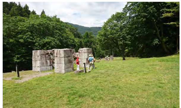
橋野鉄鉱山(高炉場跡)
