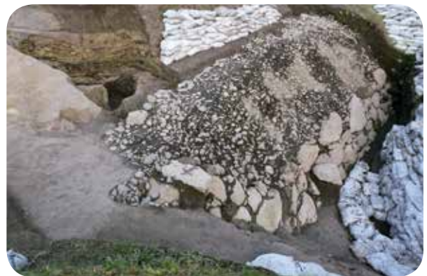
二の丸大手土橋から見つかった石垣
